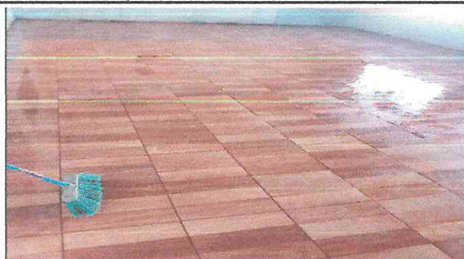
Foto 1: INSTALACIÓN DE PISO CERAMICO EN AULAS FINALIZADO.
