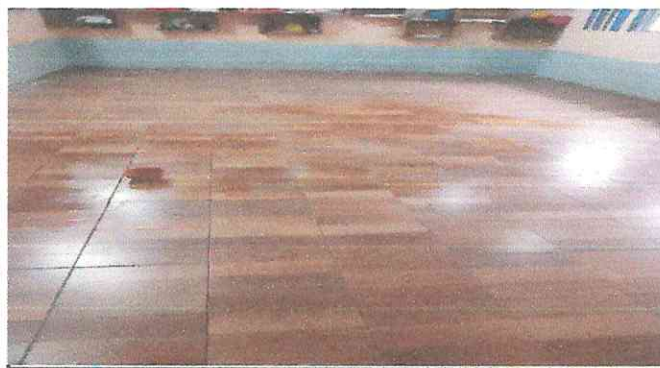
Foto 3: INSTALACIÓN DE PISO CERAMICO EN AULAS FINALIZADO.
