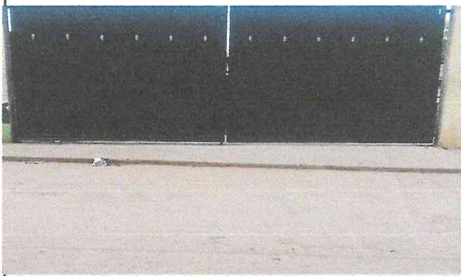
Foto 4: MANTENIMIENTO DE PORTON FINALIZADO
